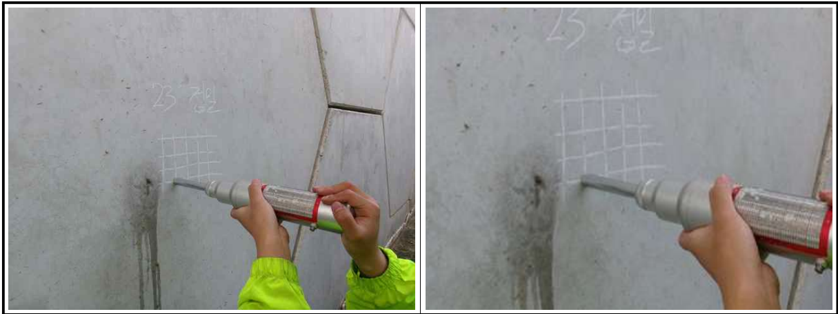
【그림 14.3.6】 슈미트해머를 이용한 반발경도시험 전경
